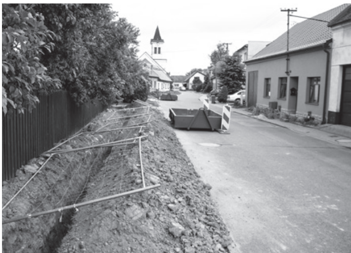
Výstavba nového veřejného osvětlení a chráničky optického kabelu v ulici Kout.
