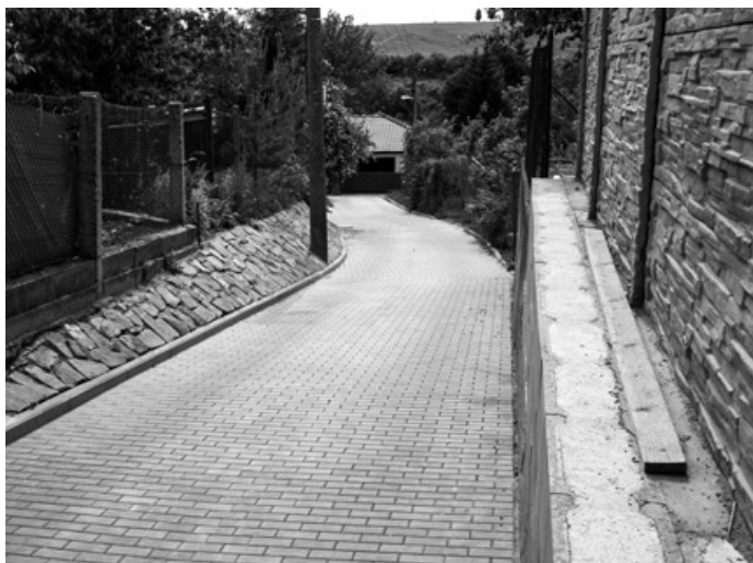
Zpevnění opěrné zdi v ulici u Rybového.
