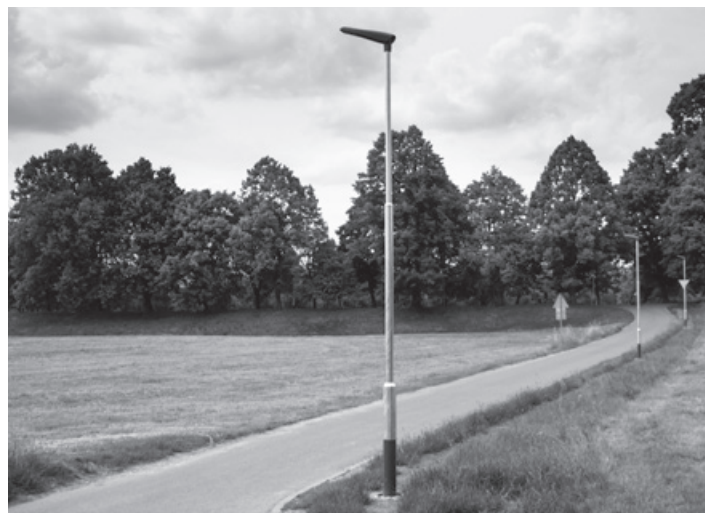
Výstavba nového veřejného osvětlení a chráničky optického kabelu u hřbitova.
