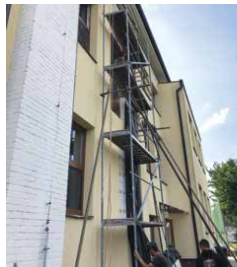
Přístavba nákladního výtahu ZŠ.
