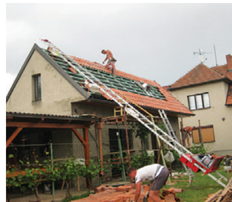
Střecha hospodářské budovy na faře byla nově zastřešena.
