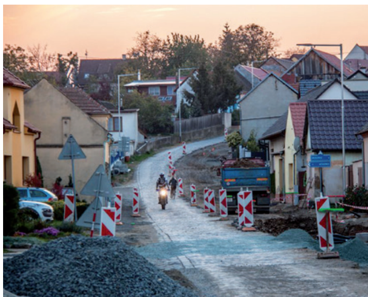
Omezení dopravy v průběhu rekonstrukce silnice.
