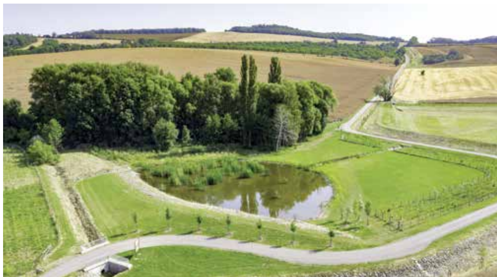
Soubor staveb Němčany (Jihomoravský kraj) – po realizaci.
