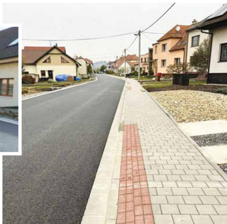
Školní ulice, kde došlo ke kompletní opravě chodníků a místní komunikace.
