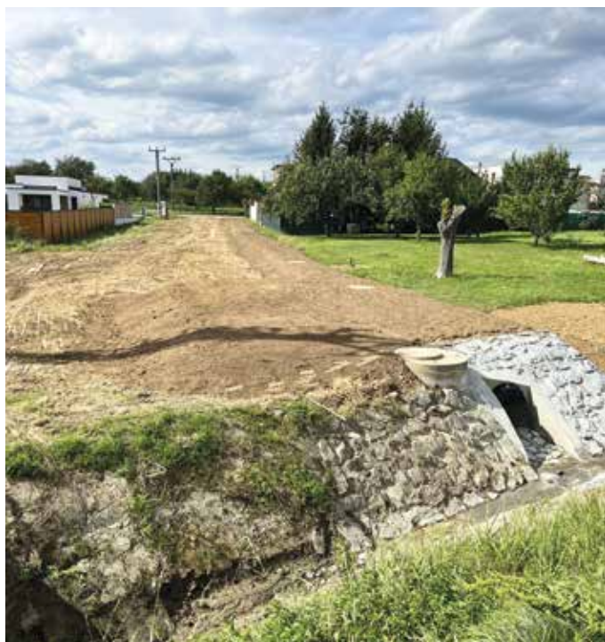
Nově vybudovaná stoka A1.1 včetně odlehčovací komory v Olších.
