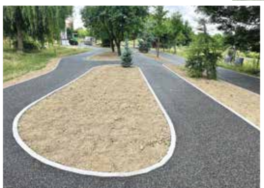
Obnova sportovní plochy v zahradě ZŠ Zlechov – podložka pod finálním povrchem.
