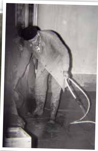
I další občané přišli na pomoc obyvatelům Kouta, kde povodeň značně poškodila zástavbu.
