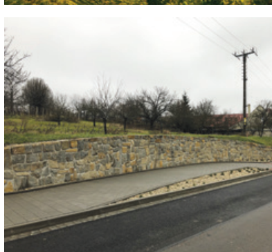
Opěrná zídka na začátku cyklostezky.
